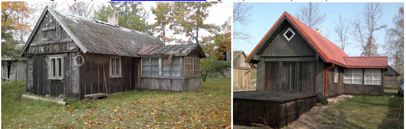
57.att. Bernātu “Irbēni” pirms un pēc rekonstrukcijas (2012-2014).
