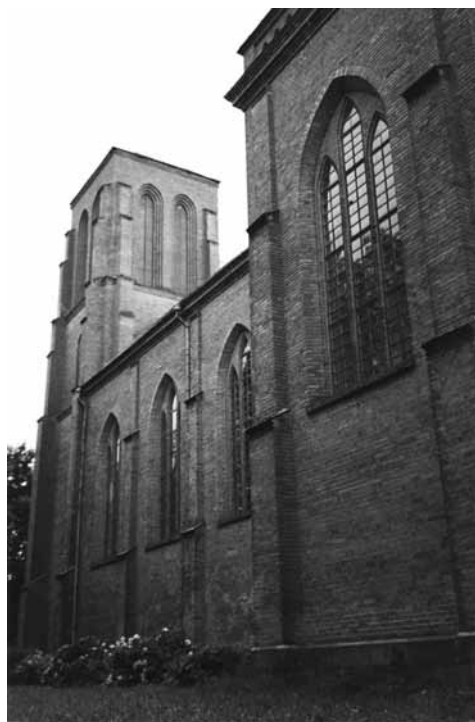
14. att. Kamaju katoļu baznīca (1903–1909, būvīnž. F. fon Viganovskis)
